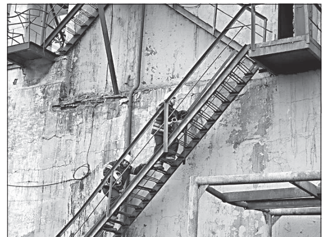
↑ Огнеборцам предстоит работать на большой высоте: примерно на уровне пятиэтажного дома. Подъем - по наружной лестнице.
